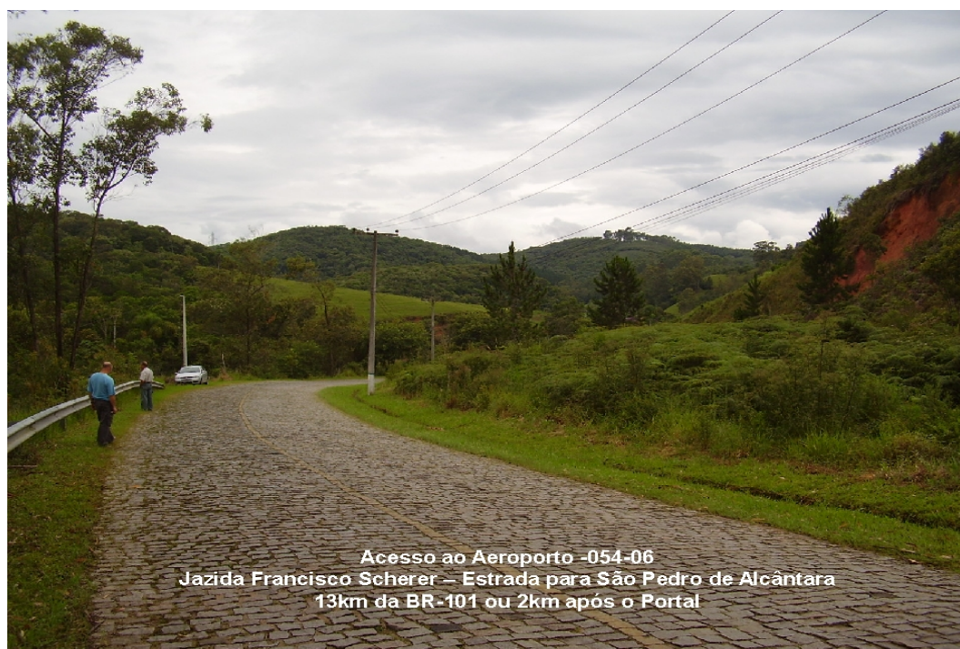
Figura 5.5 - Caixa de empréstimo Scherer, situada no acesso a São Pedro de Alcântara, a 2 km do Portal.
