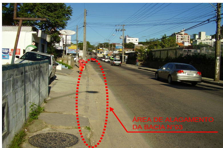
Figura 7.1 - Área de alagamento da Avenida Antônio Edu Vieira, devido ao assoreamento do talvegue da bacia n°03
