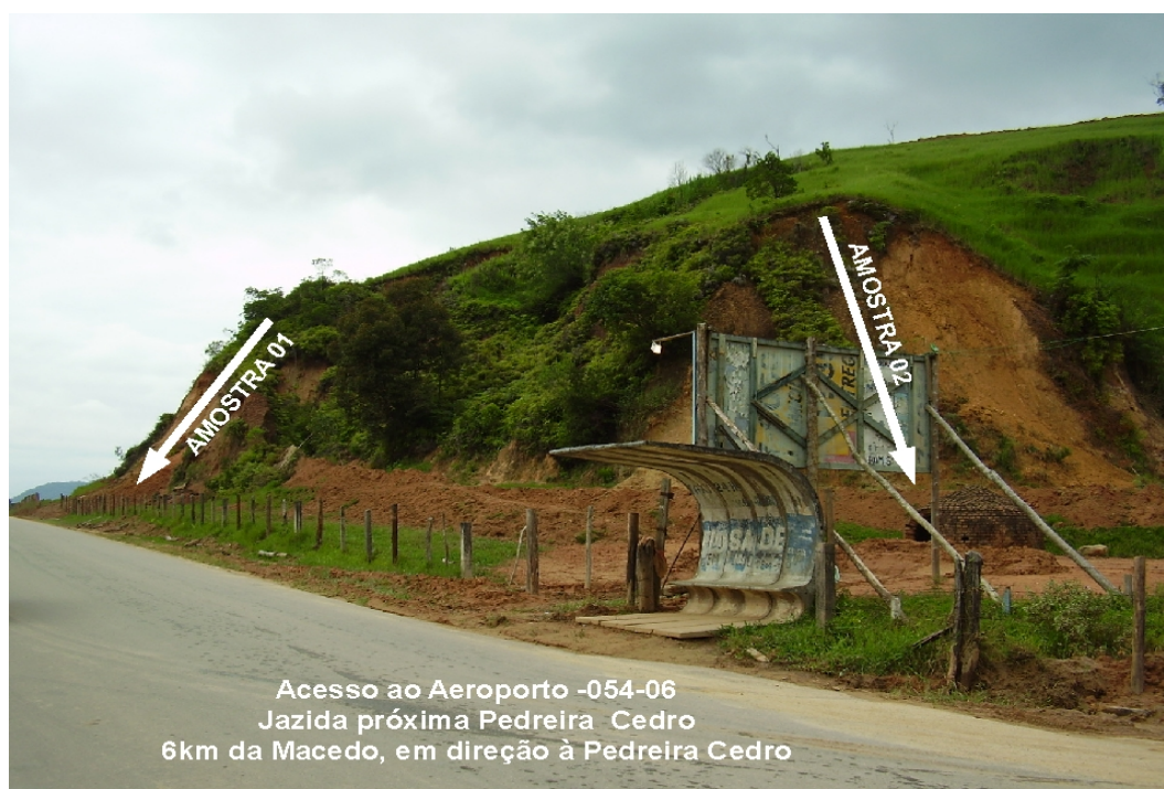
Figura 5.3 - Caixa de Empréstimo Forquilhas, situada próximo do acesso à Pedreira Cedro.
